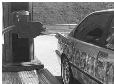
Figura 4. Estación de repostaje de \text{H}_2 en el aeropuerto de Munich
