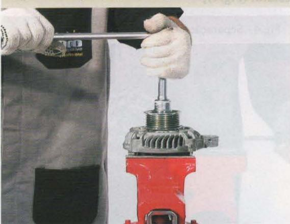
8-Separe o rotor do mancal anterior, utilizando um martelo de baquelite, ou se necessário, utilize um extrator (Fig.8);
