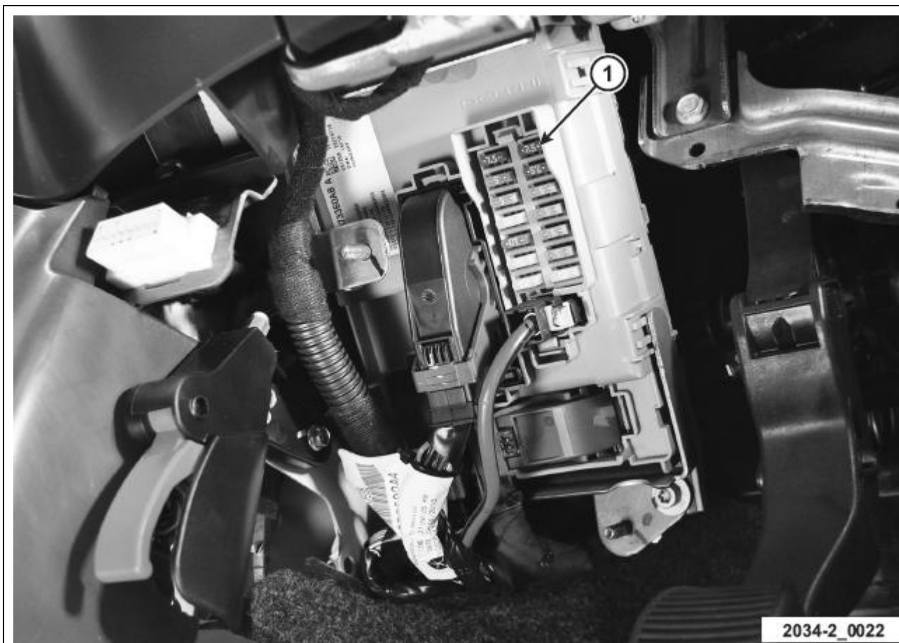
1 Tablero de fusibles del BCM
