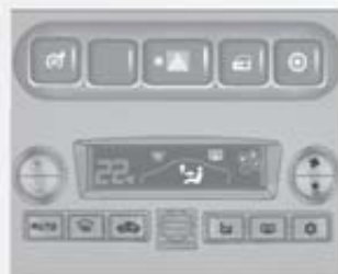
Control electrónico del acondicionador de aire
