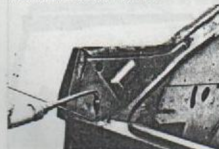
Cobresoldadura de unión de esquina de panel trasero.
