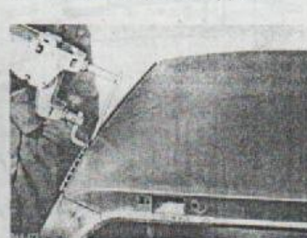
Soldadura por puntos de nuevo panel de techo a lo largo de vierteaguas.
