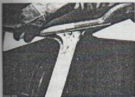
Maquinado de zona rellena con soldador en el pilar «B».
