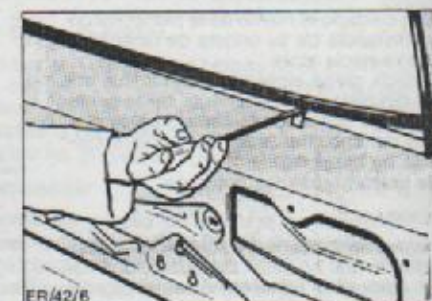
Extracción del junquillo de la zona de cintura de la puerta.
