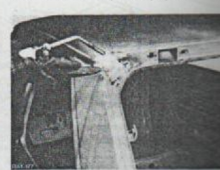
Relleño con soldadura de unión entre panel de techo y pilar «C».
