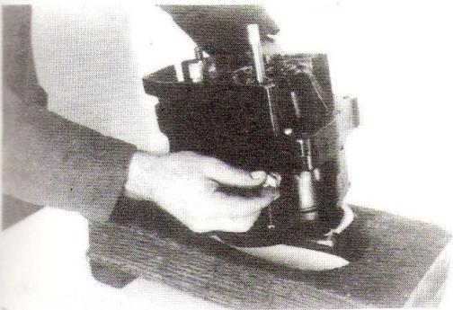
**Fig. 21:** Empezaremos por vaciar el aceite del motor, desmontando el tornillo vaciado.
