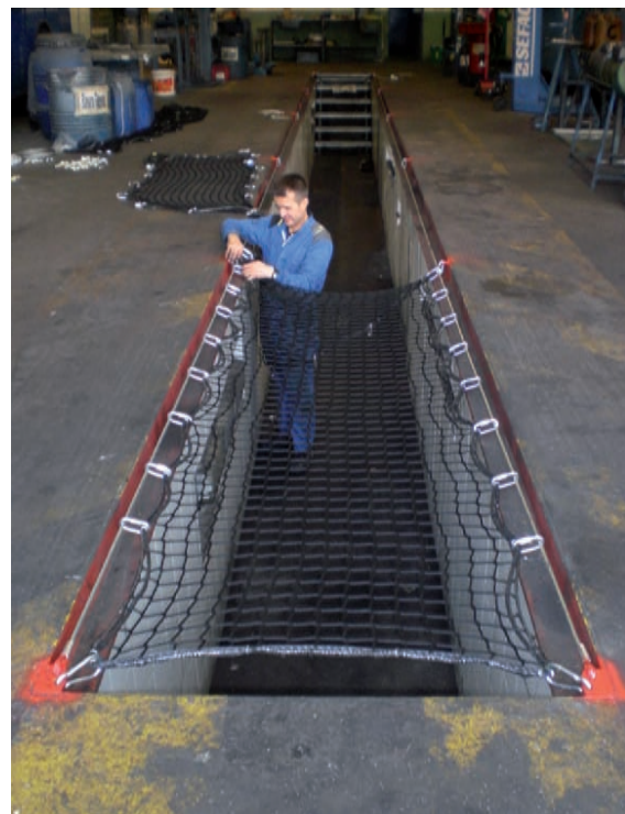
En la imagen podemos apreciar como se monta el Secured, fijando los ganchos al cable de hierro que recorre todo lo largo que es el foso.
