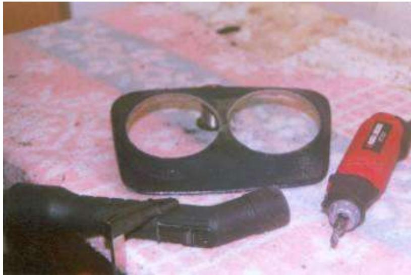
le pasamos una lija fina y si aparecen irregularidades las enmasillamos y lijamos de nuevo. Solo nos quedara montar las rejillas a presión por encima y colocar los altavoces por debajo. La sujeción de estos es variada, se pueden colocar con tornillitos pequeños (que no traspasen), hacer unos pequeños soportes con maderitas o sujetarlos con toques de cola caliente.
