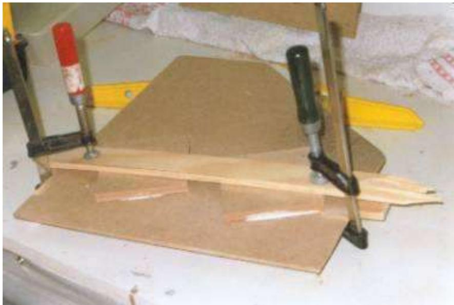
seguidamente realizamos un borde de madera de la altura del filtro con mayor grosor
