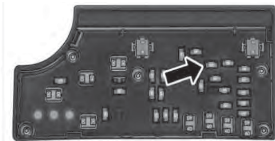
Fusible de la toma de corriente
