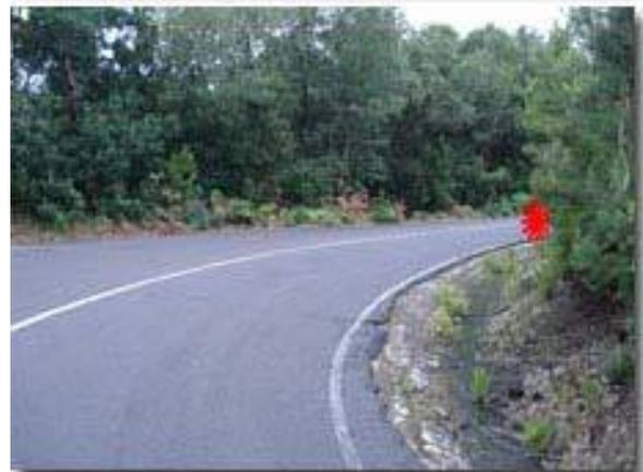
Figuras 2.4 y 2.5: El punto de fuga en la curva (estrella roja) es un punto dinámico que se mueve y se aleja conforme se recorre la curva. En la figura inferior el punto de fuga ya coincide con el punto de salida de la curva.
