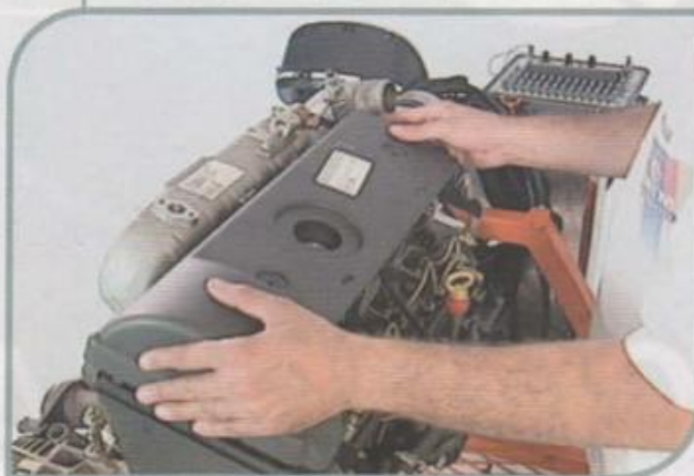
Remoção da cobertura plástica
