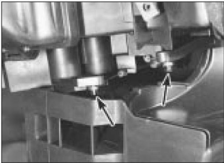
8.6c Conexiones del cable de control a las válvulas de aleta en la unidad de la caja de distribución del calentador (flecha)
