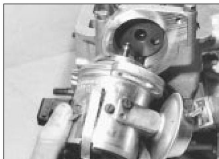
11.8 Reposición del distribuidor de encendido
