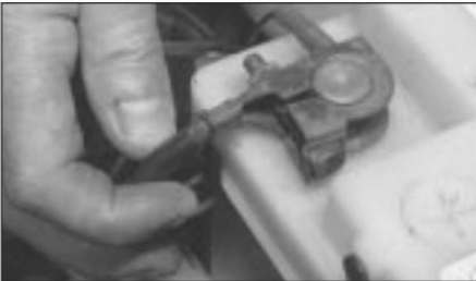
D Verificar la seguridad y el estado de las conexiones de la batería.
